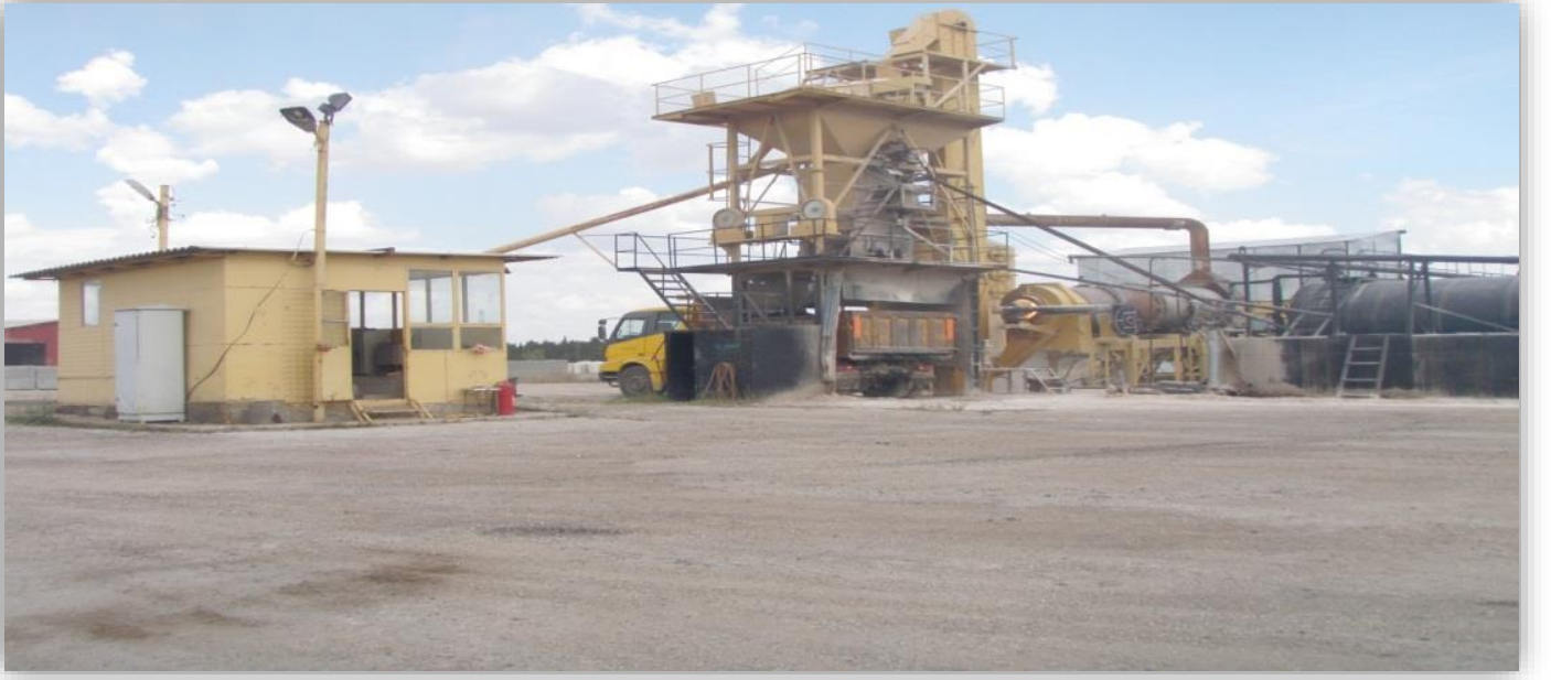
HAVSA ASFALT ŐANTIYESİ
